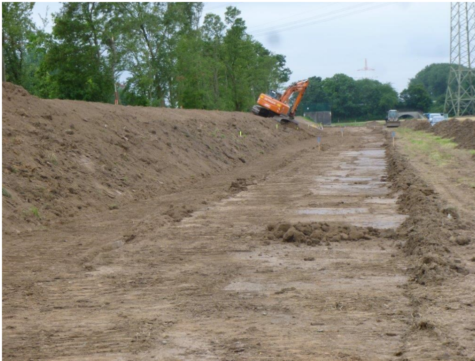
Wie hier am Deich gegenüber dem Kraftwerk Lahde werden die letzten Deichabschnitte am Schleusenkanal Petershagen mit schwerem Gerät ertüchtigt. Foto: WSA)
