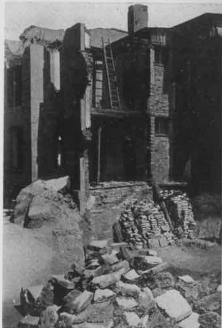
Haus Gronemann in Leteln nach einem Luftangriff
