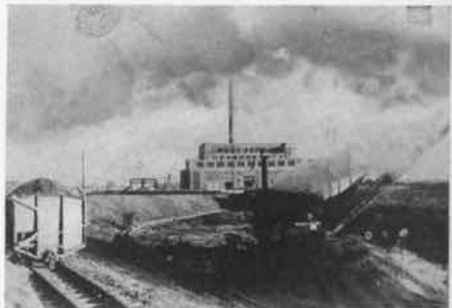
Kraftwerk Lahde im Wiederaufbau.
