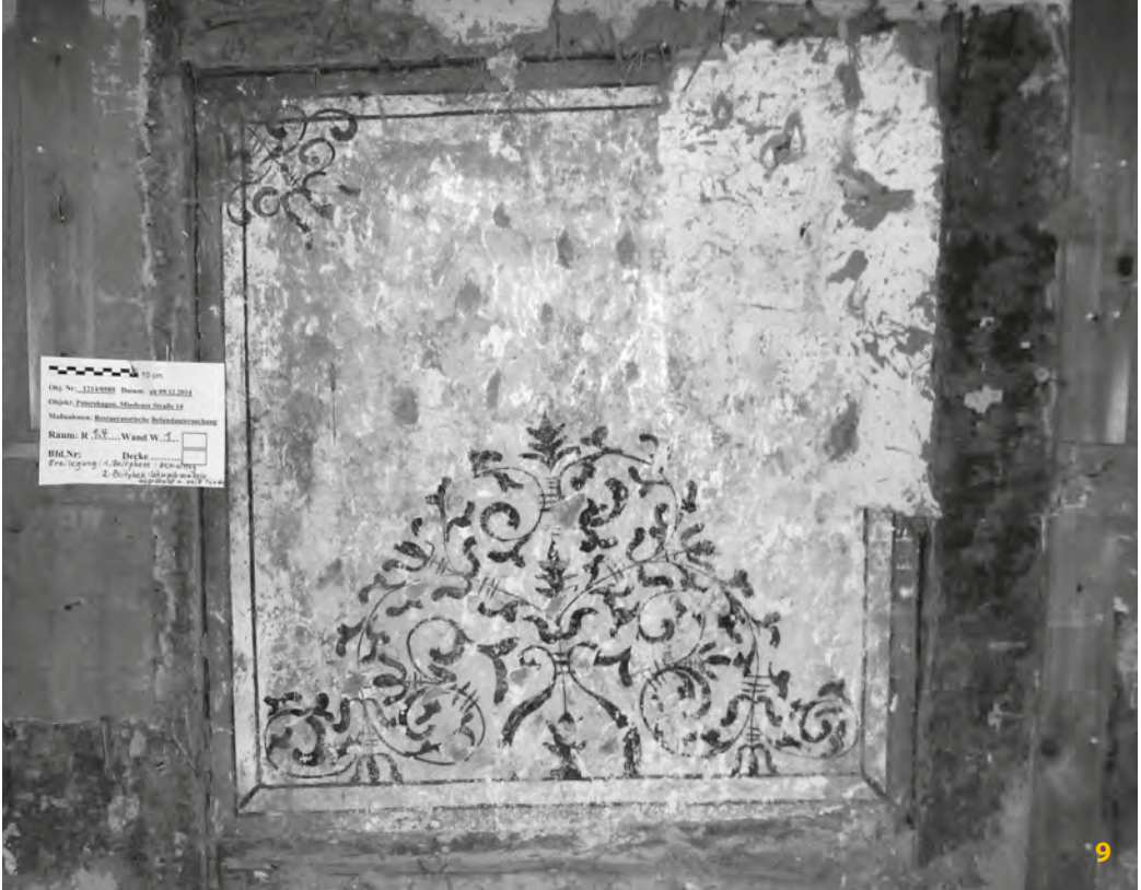
9 Die im Juni 2015 freigelegte bauzeitliche Gefachmalerei in der Saalkammer überraschte aufgrund ihrer Qualität alle Beteiligten. Noch im 17. Jahrhundert wurden diese Gefache überputzt und geweißt. (Foto: 2015 P. Barthold/LWL)
