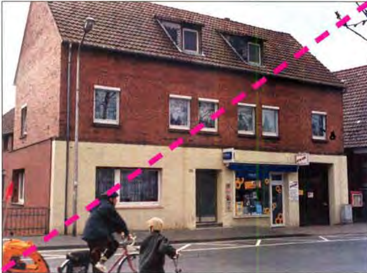
Durch die Verklammerung mit gelben Riemchen fallen Erd- und Obergeschoss auseinander. Verstärkt wird dieser Eindruck noch durch die nicht aufeinander bezogene Fensteranordnung.
