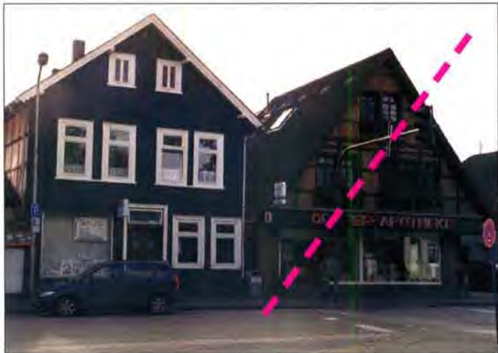
Die Mittelsymmetrie ist an der schieferverkleideten Fassade des Fachwerkhauses links trotz eines störenden Schaufensters noch klar zu erkennen, während der Neubau rechts dieses Gestaltungsprinzip ignoriert. Dort sind auch Erd- und Obergeschosse nicht als flächige Einheit wahrnehmbar.
