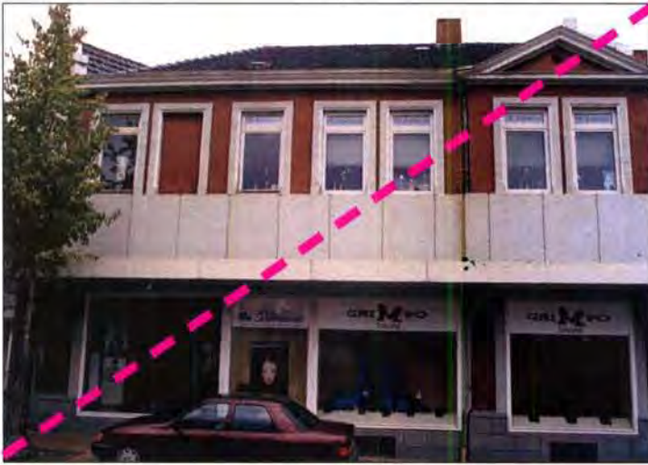
Der plumpe, überdimensionierte Betonfries zerstört völlig die noble Wirkung der Mauerwerksfassade (die nach dem Einbau von Schaufenstern allerdings nur noch im Obergeschoss spürbar wird).
